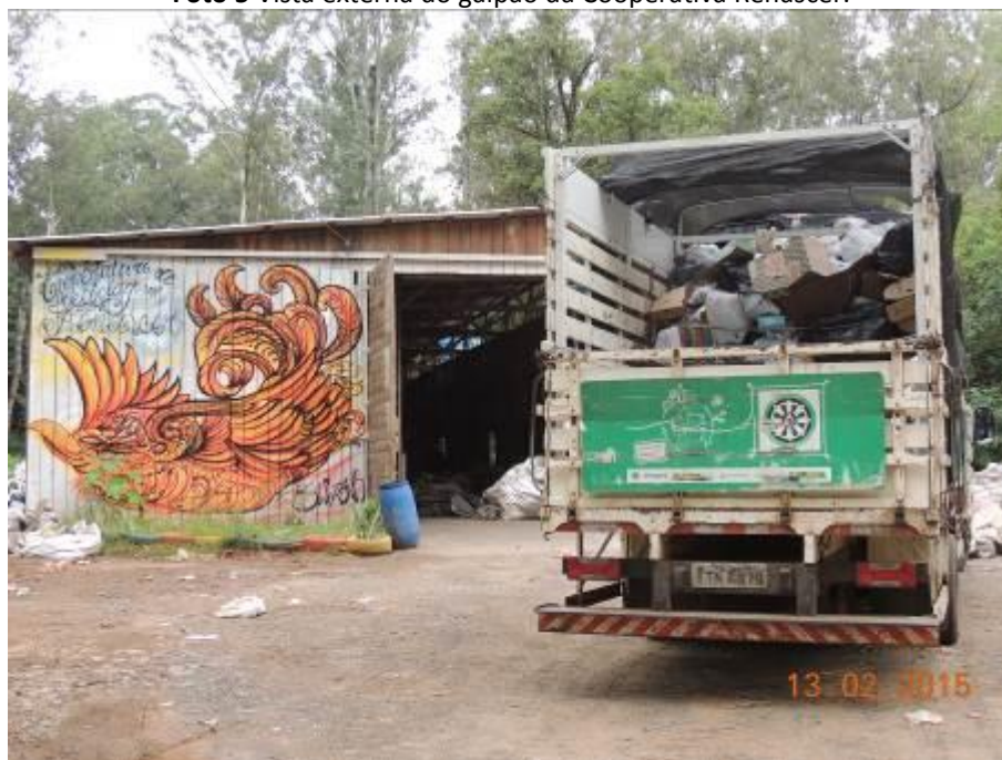
Foto 5 Vista externa do galpão da Cooperativa Renascer.
