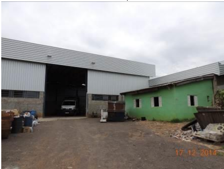
Foto 3 Vista externa da Cooperativa Coarlas.
