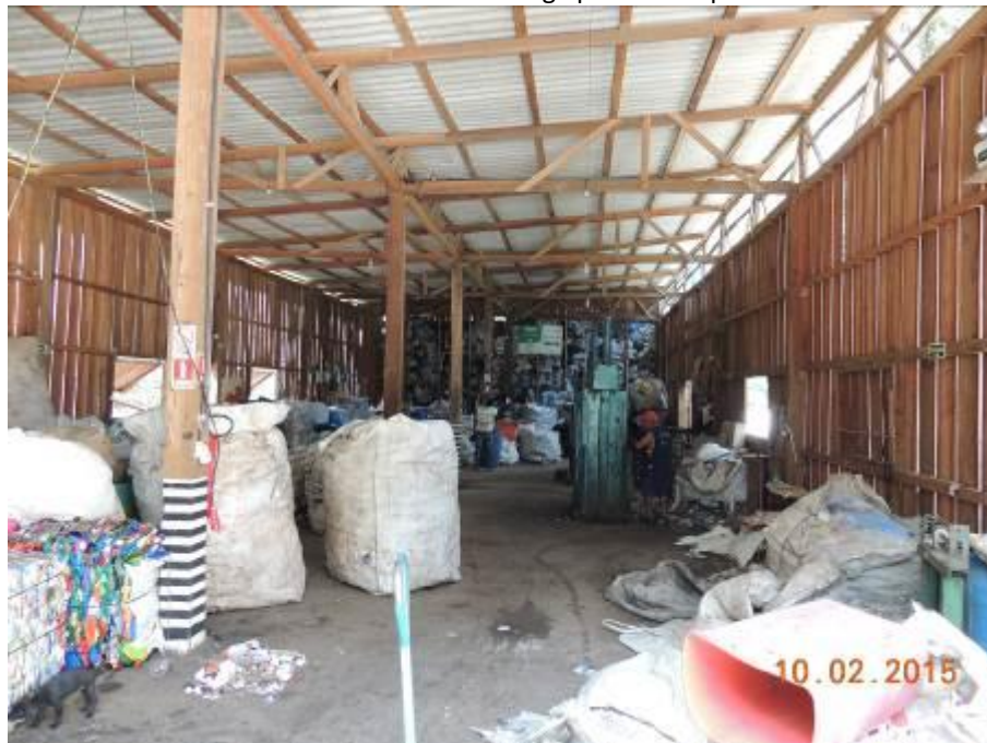
Foto 6 Detalhe da estrutura interna do galpão da Cooperativa Renascer.
