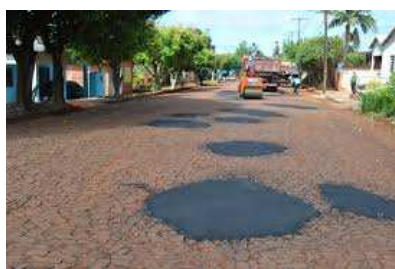
Figura 1: operação tapa buraco
