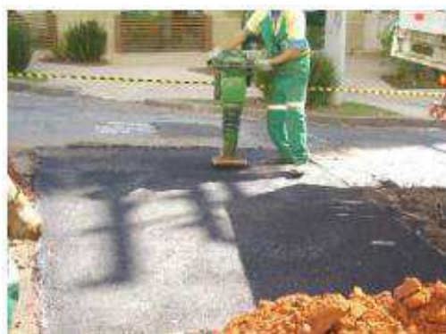
Figura 6: compactação do CA
