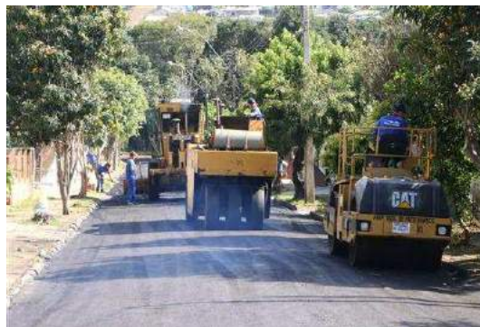
Figura 13: compactação do CA de reperfilagem
