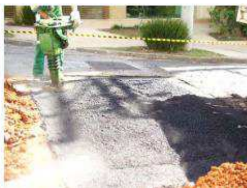
Figura 5: compactação do CA
