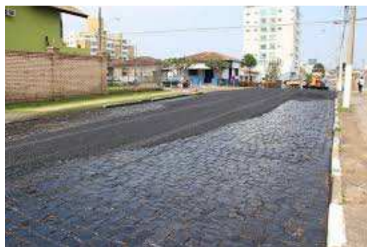
Figura 11: revestimento com pintura de ligação
