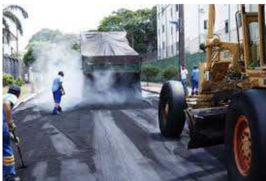
Figura 12: reperfilagem com CA
