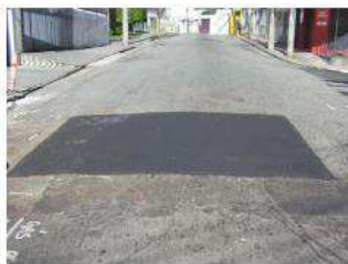
Figura 7: Remendo superficial executado
