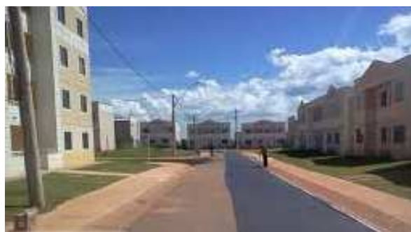
Figura 16: rejuvenescimento com micro revestimento asfáltico
