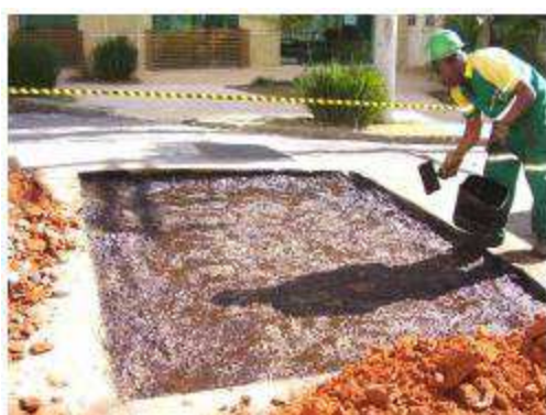
Figura 4: imprimação da camada de base
