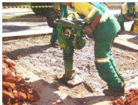
Figura 3: readequação da camada de base
