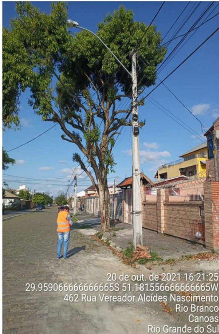
Figura 50 - Exemplo de ponto com obstrução da iluminação por árvores
