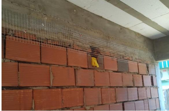
Imagem ilustrativa de aplicação de telas de aço galvanizado malha 15x15mm na estrutura superior de concreto
