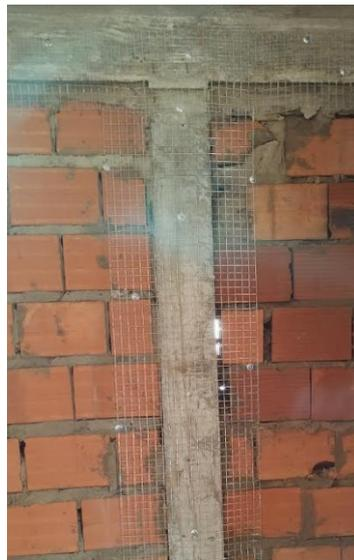
Imagem ilustrativa de aplicação de telas de aço galvanizado malha 15x15mm na estrutura concreto - pilar
