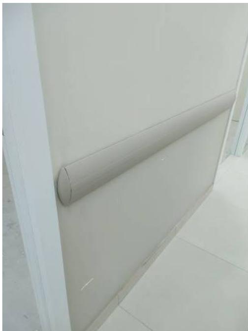
Imagem do protetor de parede em PVC, conforme especificação.
