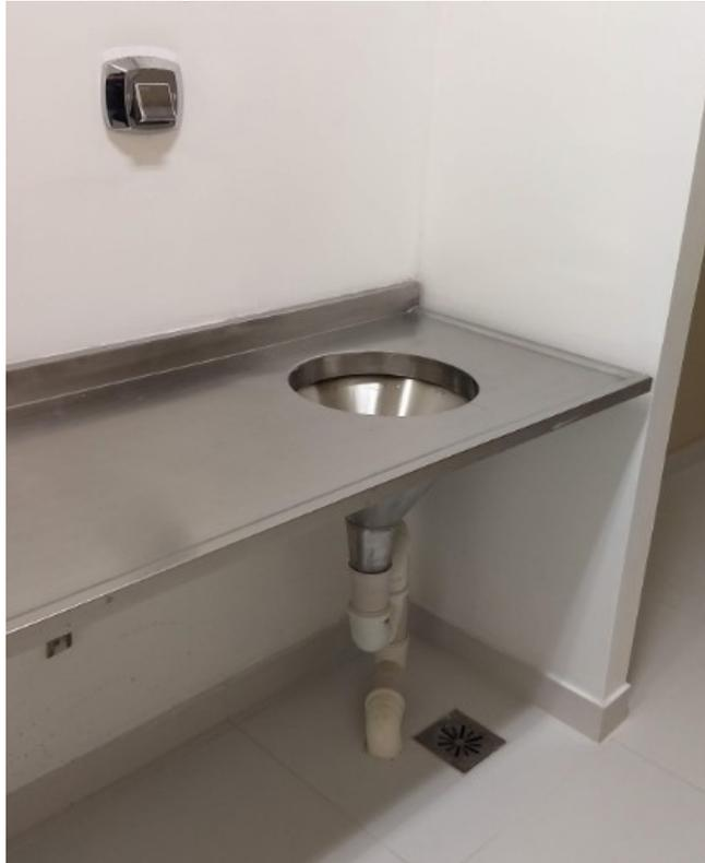
Imagem ilustrativa - tampo em inox com expurgo, sifão em tubos de PVC e acionamento por válvula de descarga
