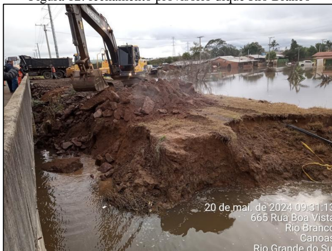
Figura 12: fechamento provisório dique Rio Branco
