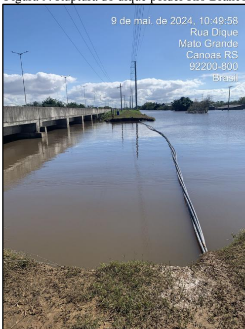
Figura 9: Ruptura do dique polder Rio Branco
