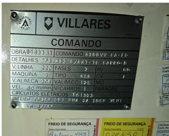
Figura 9: Casa de Máquinas – placa de identificação do comando
