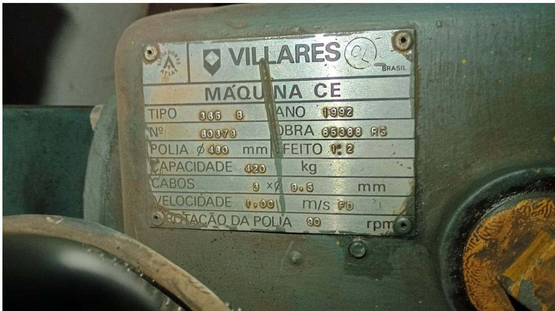
Figura 6: Casa de Máquinas – placa de identificação equipamento de tração
