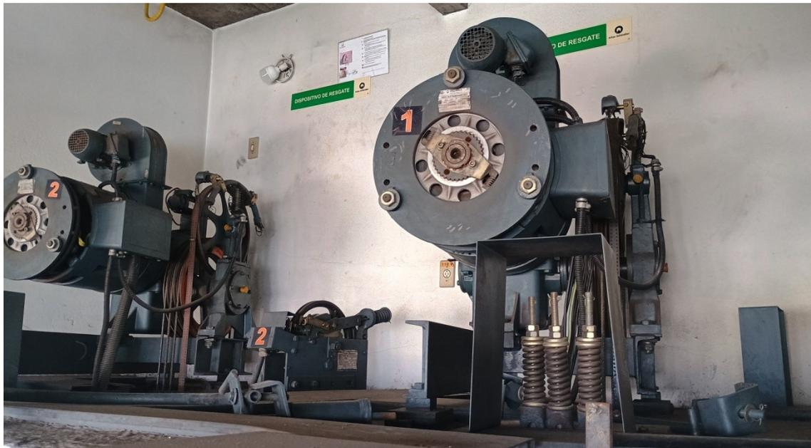
Figura 5: Casa de Máquinas – visão dos equipamentos de tração e frenagem
