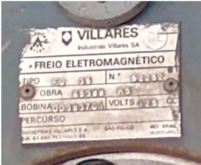
Figura 7: Casa de Máquinas – placa de identificação de freios
