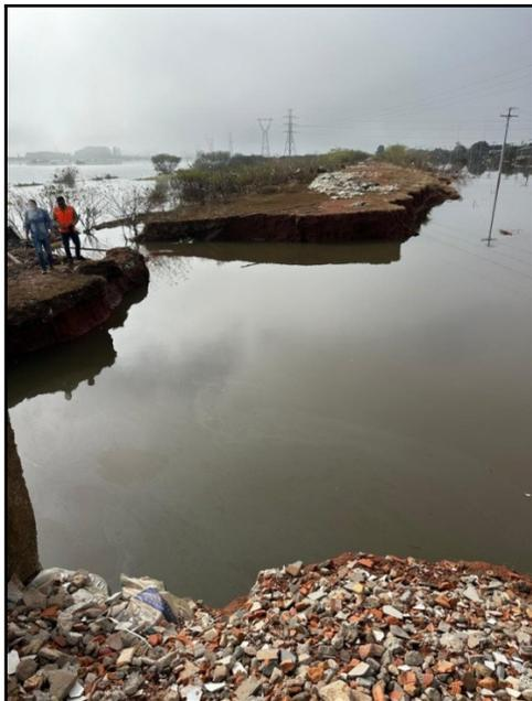
O rompimento dos diques, após análise das brechas de ruptura, se deu em função do galgamento (figura 11) que ocorre quando as águas externas vertem sobre a crista da barragem de terra causando erosão no talude de jusante formando uma brecha de ruptura de forma regressiva causando o colapso daquela seção de dique fragilizada.
