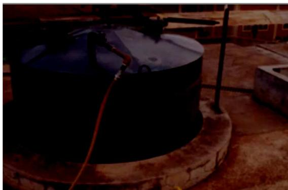
**Biodigestor Chinês (ou de Cúpula Fixa)**
