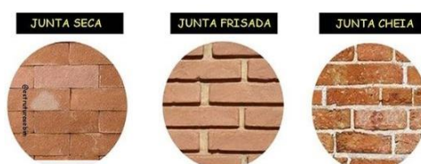
Tipos de juntas. Imagem extraída do Pinterest, perfil ESTRUTURASEBIM.COM
