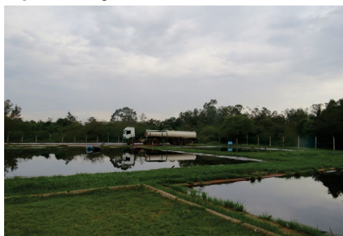
Figura 33 Lagoas de chorume do Aterro Sanitário Guajuviras desativado
