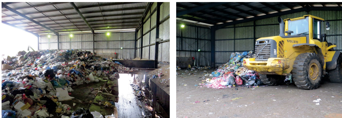
Figura 31 Estação de Transbordo no Aterro Guajuviras
