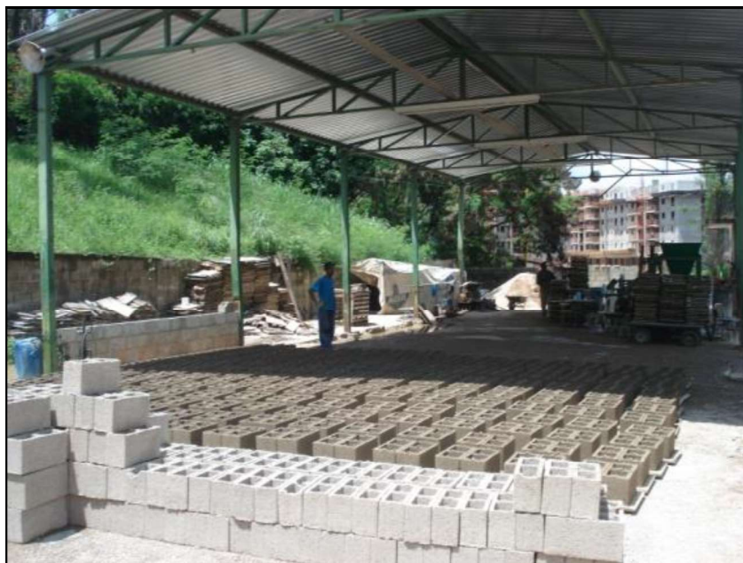
Figura 52 Produção de blocos de concreto com agregado reciclado – PBH (2010)
