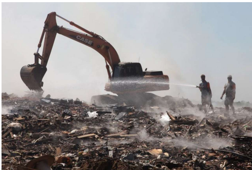
Figura 26 Incêndio sendo combatido em 2012
