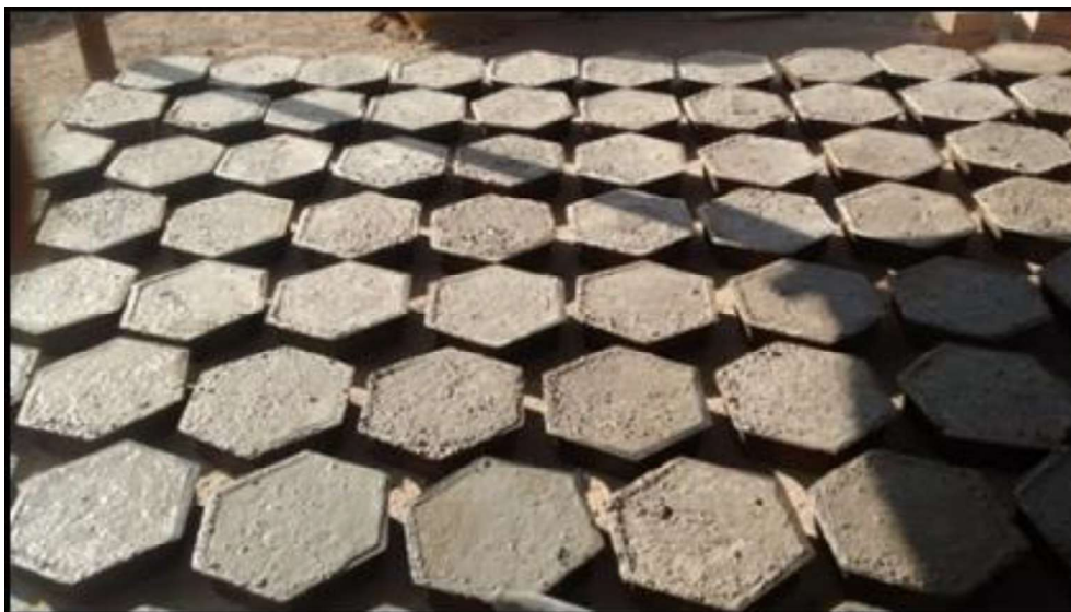
Figura 53 Produção de pisos de concreto com agregado reciclado – URMIGEL – Pará de Minas/MG (2014)
