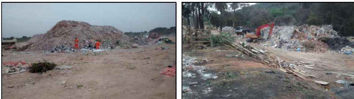
Figura 43 Triagem manual realizada atualmente e exemplo de triagem com apoio de escavadeira
