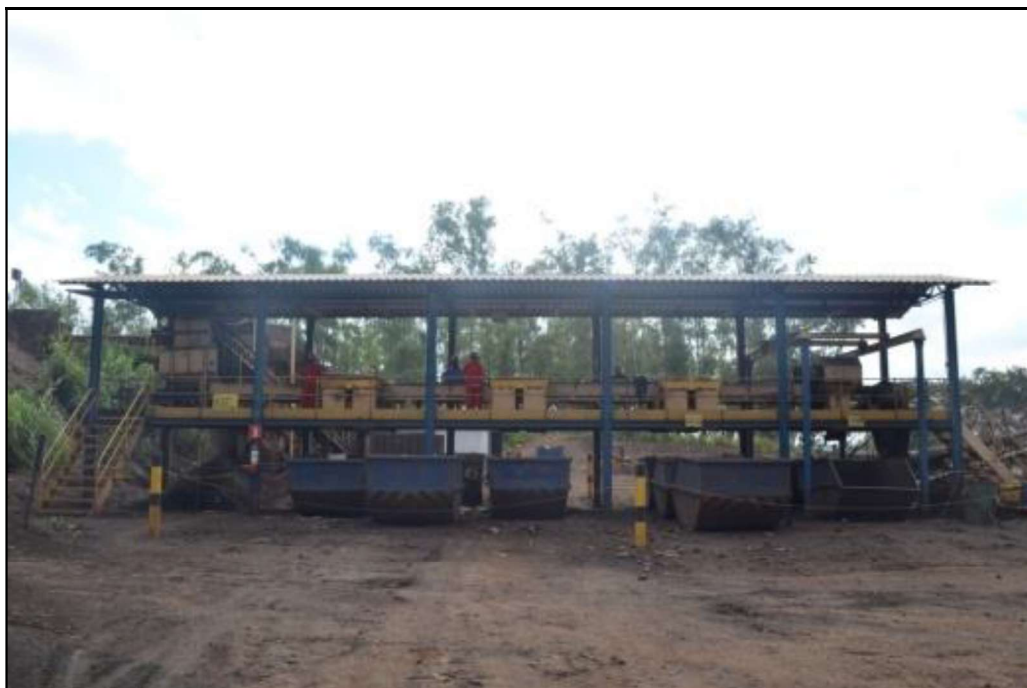
Figura 46 Exemplificação de esteira de triagem elevada – Visão Geral – Vallourec
