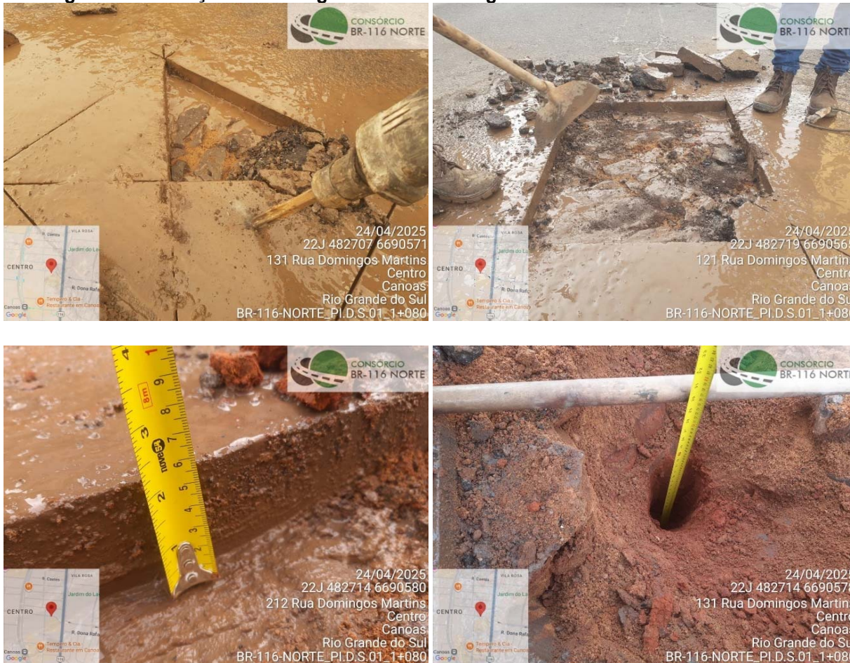
Figura 5 – Execução da sondagem na Rua Domingos Martins – km 0+000 ao km 0+221
