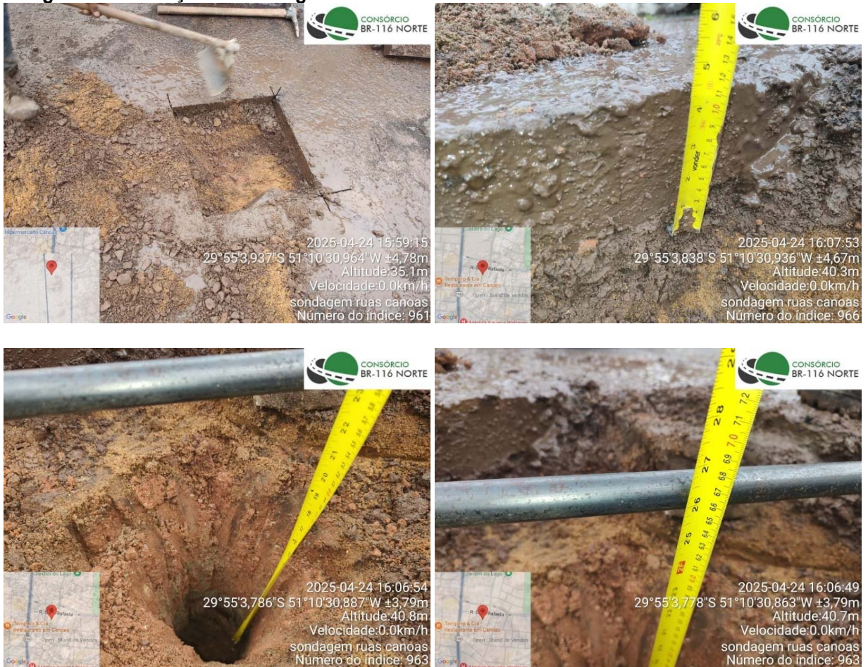
Figura 9 – Execução da sondagem na Rua Santa Cecília – Ramo C – km 1+370 ao km 1+532
