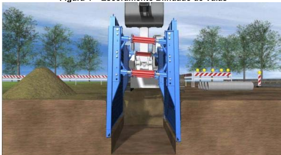
Figura 4 – Escoramento Blindado de Valas
