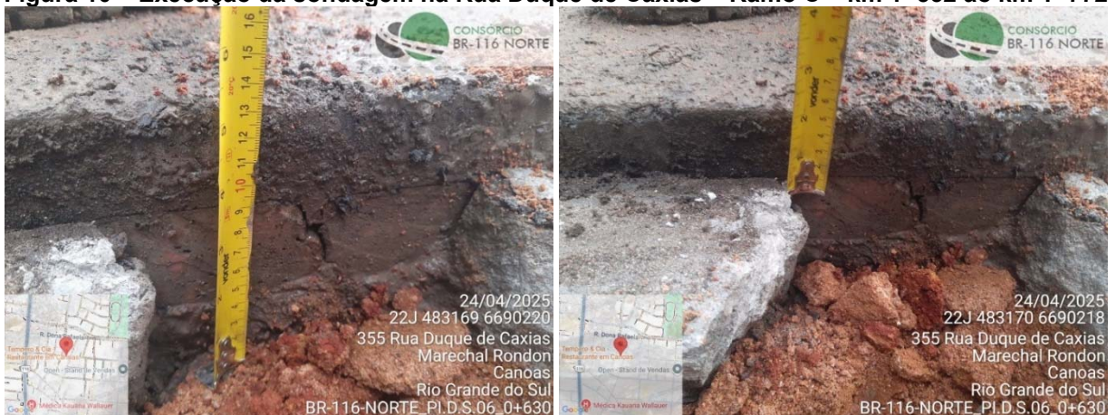
Figura 10 – Execução da sondagem na Rua Duque de Caxias – Ramo C – km 1+532 ao km 1+772
