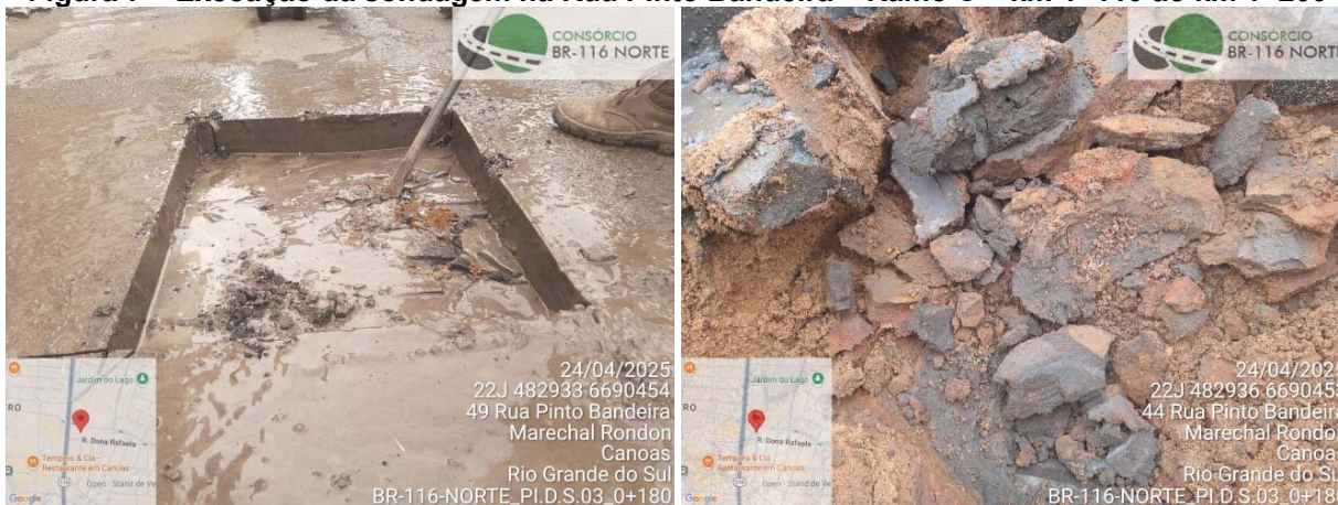
Figura 7 – Execução da sondagem na Rua Pinto Bandeira – Ramo C – km 1+110 ao km 1+200
